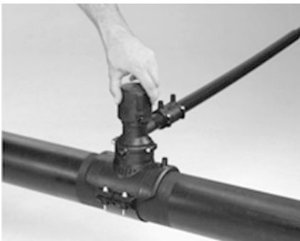
13 Schraub- bzw. Schweisskappe von Hand fest anziehen (keine Gewindedichtpasten oder Gleitmittel verwenden).
