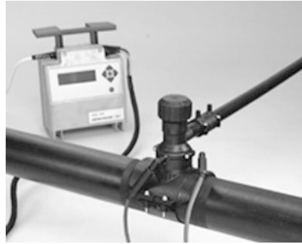
14 Schweißen der Schweisskappe gemäss Bedienungsanleitung.
